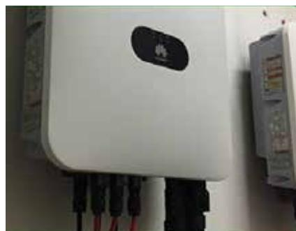
stente che dispone di una capacità nominale di 18,4 kWp suddivisi su 4 inverter ognuno con potenza pari a 4,6 kWp. Questo sistema consentirà di sfruttare e immagazzinare l'energia prodotta dall'impianto fotovoltaico consentendo un risparmio di circa 4500 Kw/ora anno pari a oltre 3.000 €/anno e alla riduzione di 1,60 tonnellate di anidride carbonica».
